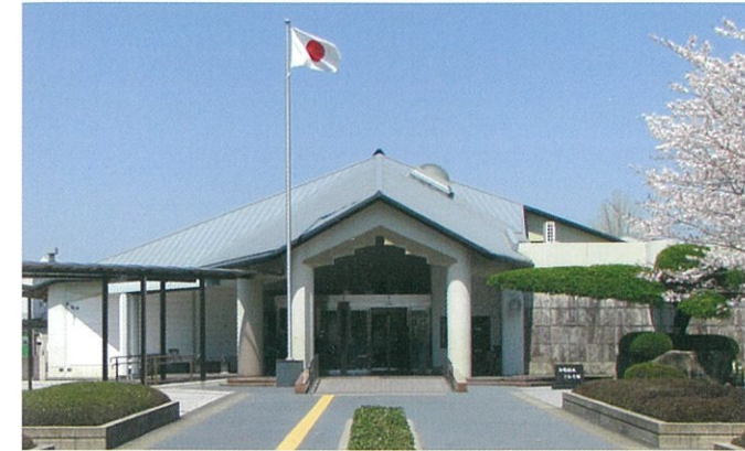
会館正面入口
