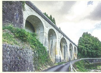
10 おろち泣き橋 この橋の下に1点に立つと、目の橋からある音が大きく聞こえるスポットがあります。4連アーチ橋をおろち(大蛇)の胴体に例え、今福線が開通しないことが決まった日から、おろちがひそかに泣き続けていると地元の人は言います。
