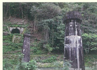
3 有福第三トンネルと橋脚 県道の桜並木を過ぎると突然遺構が現れます。対岸のトンネル坑口と橋脚のつながりにより未成線の無念さを感じさせます。見学の際は車両の通行にご注意ください。
