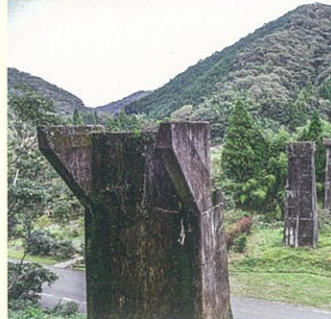
4 橋脚群 旧線では最長の橋梁です。円形の橋脚は川の流水の影響を小さくするためのものです。全国的には舟形や小判型が多く、貴重な存在です。県道を挟んだ山側には橋台と今福線第一トンネルがあり、小山に登ると橋脚群が右にカーブしている様子がわかります。
