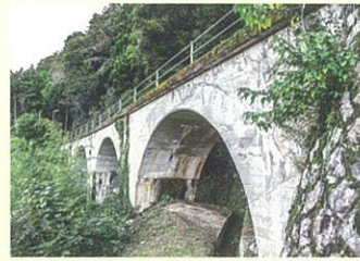
7 4連アーチ橋 今福線アーチ橋群のシンボリック的存在。コンクリートアーチ橋は、戦争による鉄不足の時代に多用されたものです。新緑や紅葉の時期には美しい景観に溶け込み、悲運の歴史を今に伝えています。橋の奥に今福第四トンネル、1連アーチ橋があります。
