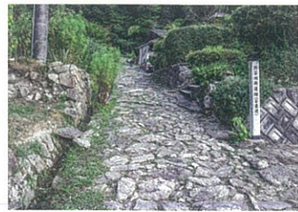
E [佐野地区] 丹後坂の石畳 江戸時代、浜田藩主の一行が参勤交代の時に、この丹後坂を通り広島へ向かいました。雨水で路面が崩れないよう、坂に石を敷き詰め流失を防いだのは当時の人の知恵でしょう。
