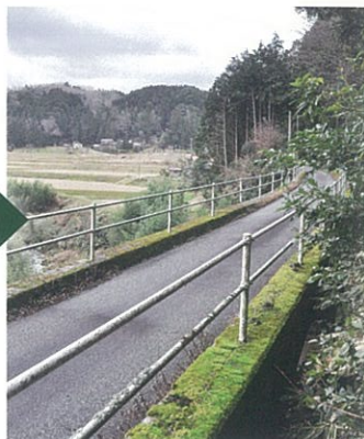
おろち泣き橋 (現在) 現在は市道に転用されており、橋の両側に落下防止のための手すりが施されています。田園風景は今も変わりません。
