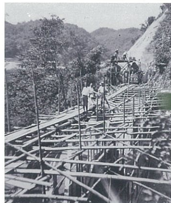
おろち泣き橋 (昭和13年頃) 下府川沿いに建設中の4連アーチ橋。当時は杉の丸太を使って足場を組んでいた様子がわかります。
